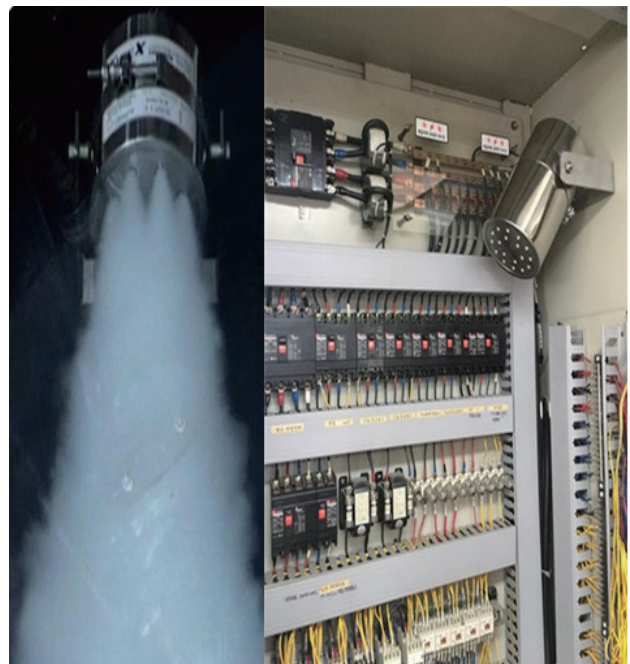
〈그림 7〉 고체에어로졸소화기의 작동 및 설치 모습
