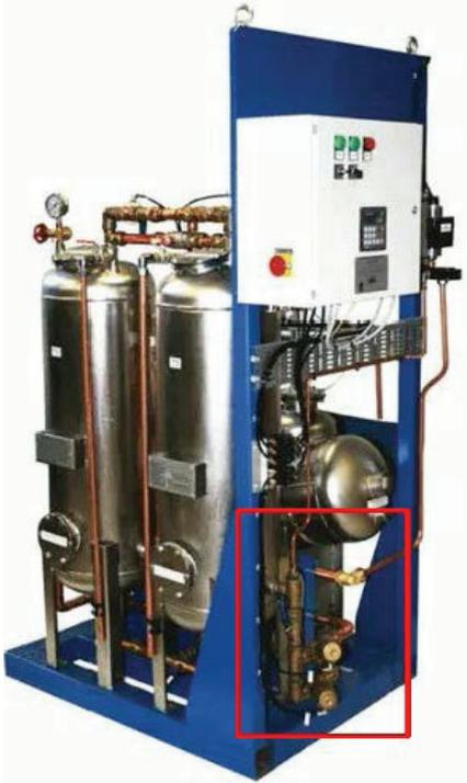
〈그림 5〉 발지 검출 및 배출 자동정지 장치
