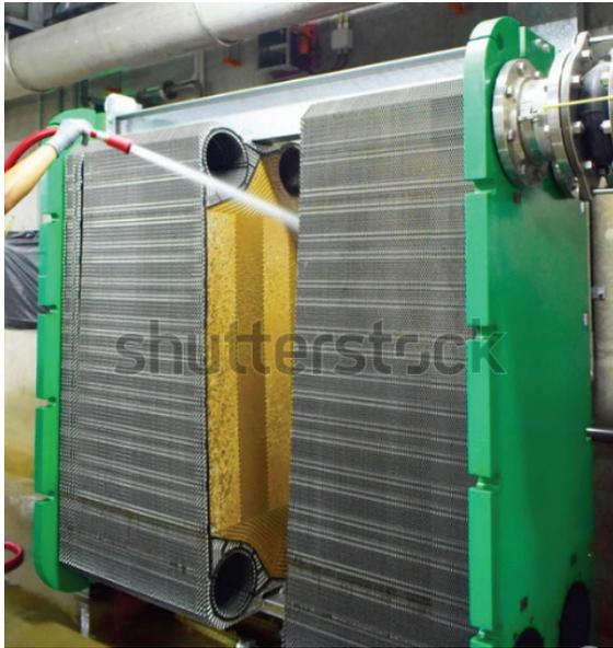
〈그림 4〉 Cleaning of cooler
